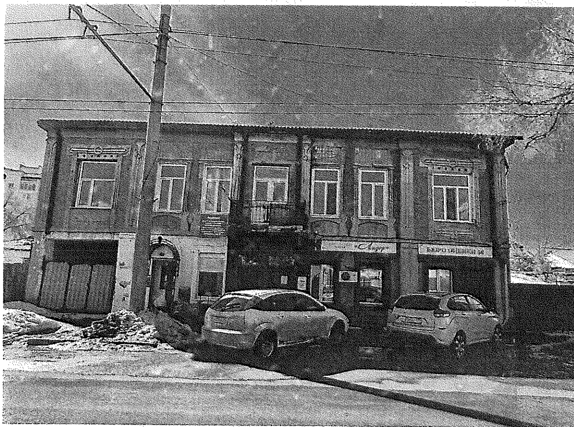
Восточный (главный) фасад. Вид со стороны ул. Комсомольской.
