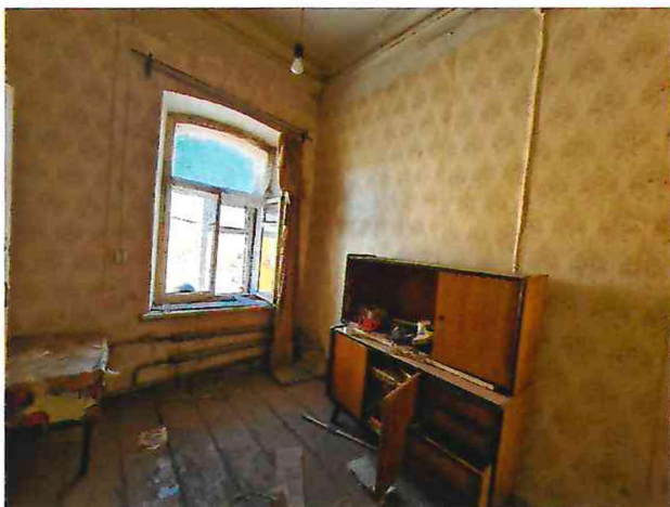
Интерьеры. Внутреннее помещение 2 этажа.
