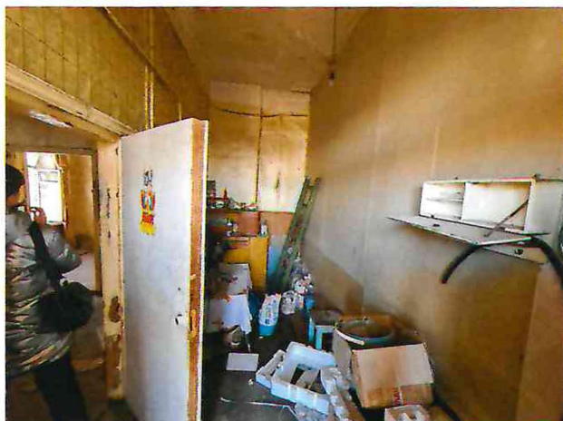
Интерьеры. Внутреннее помещение 2 этажа.
