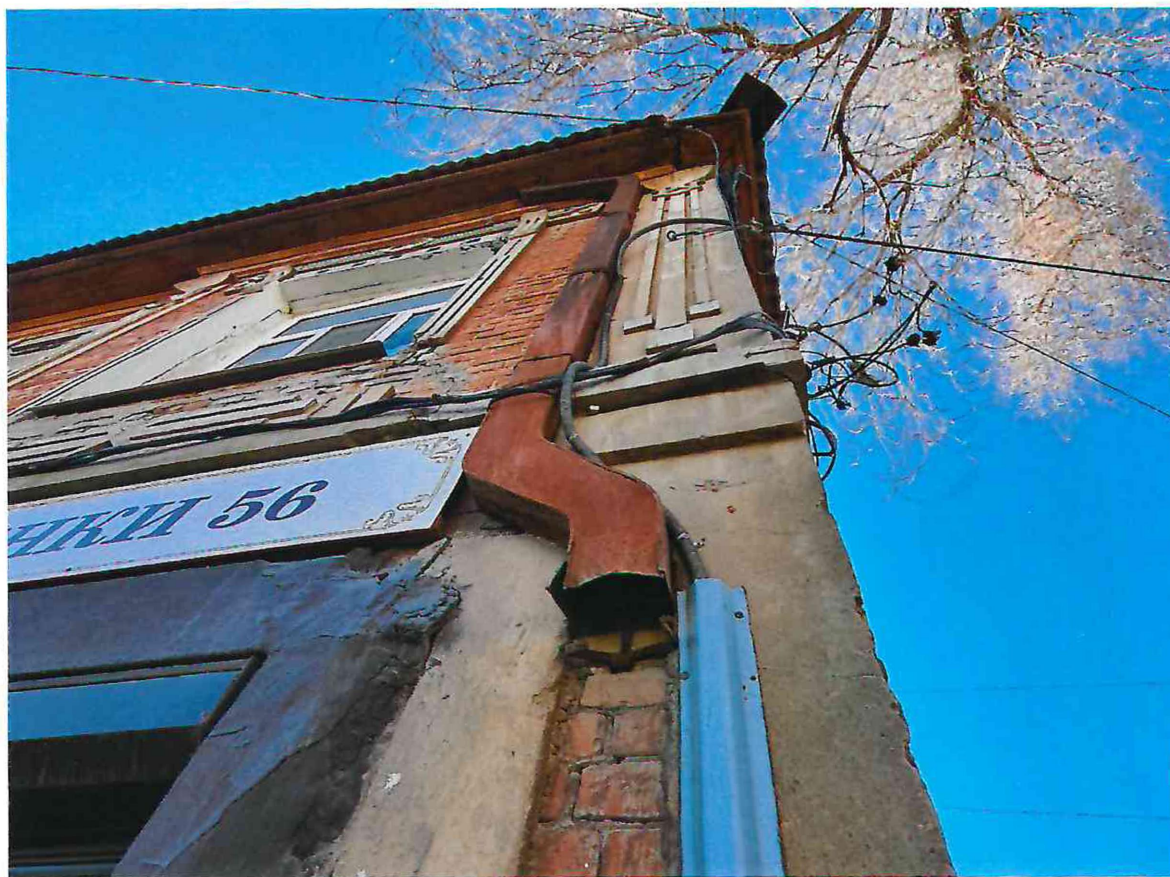
Фрагмент главного фасада. Кованые ухваты наружной системы водостока и фрагменты труб.
