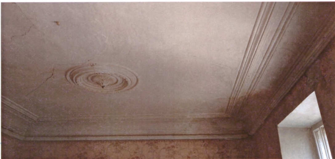
Фото 5, 6, 7. Внутренняя отделка помещения.
