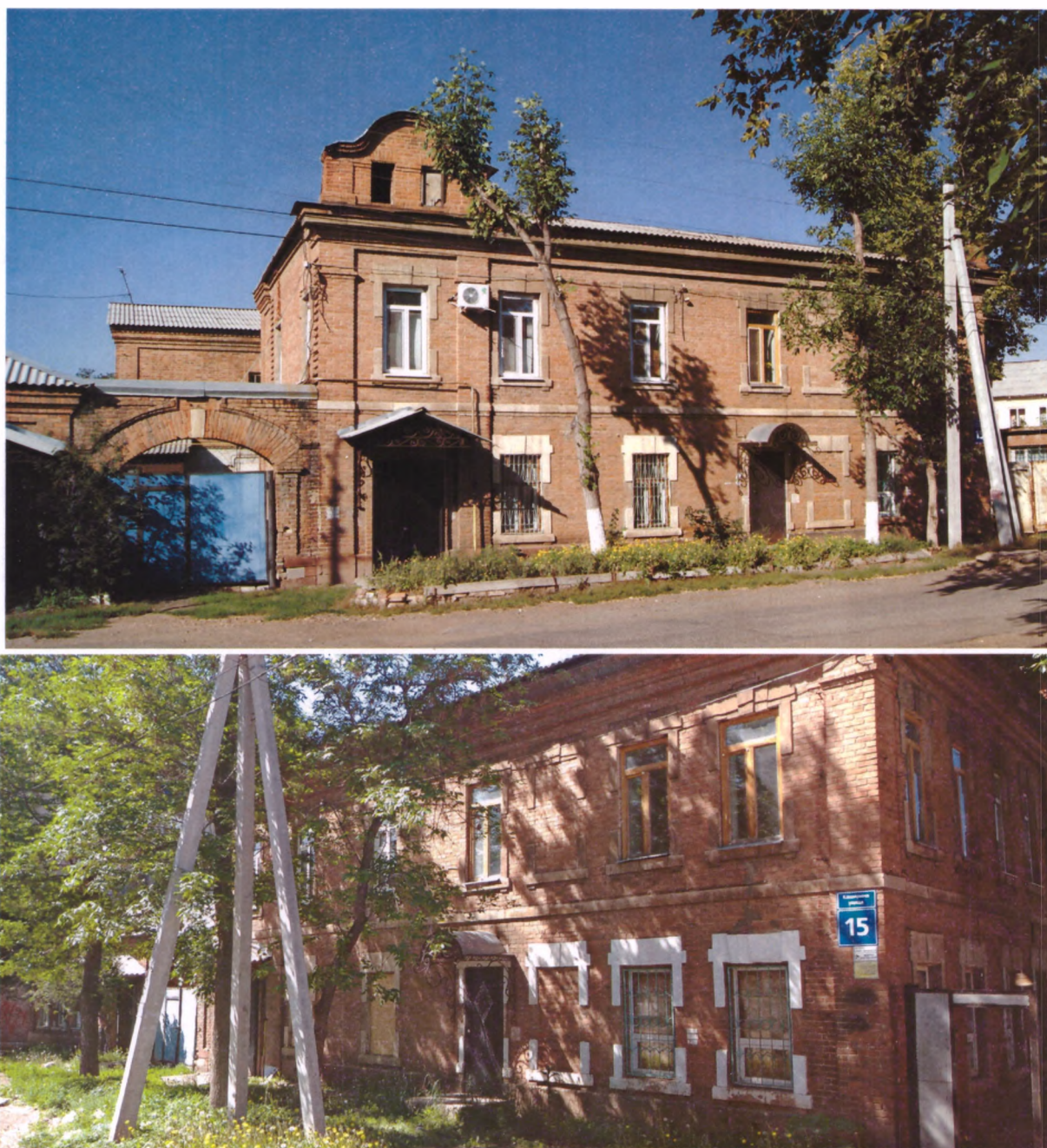
Фото 1, 2. Общий вид объекта культурного наследия.
